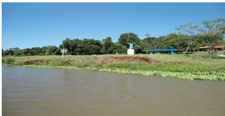
**Foto 5-2** Processo erosivo junto ao Clube, resultante da marola formada no reservatório em dias com vento acentuado (19/03/2015).
