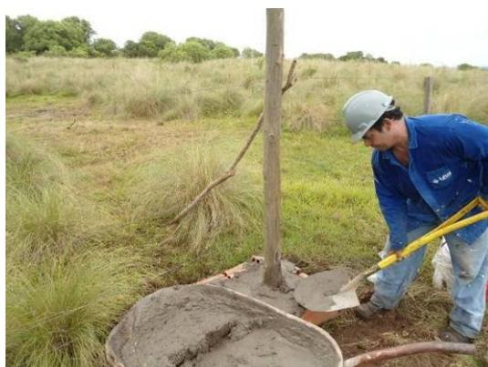
**Foto 1-30** Reforço para fixação de mourão em concreto, devido ao solo raso (19/02/2015; RO-95).
